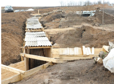
Рис. 10. Современная траншея на одном из направлений СВО
